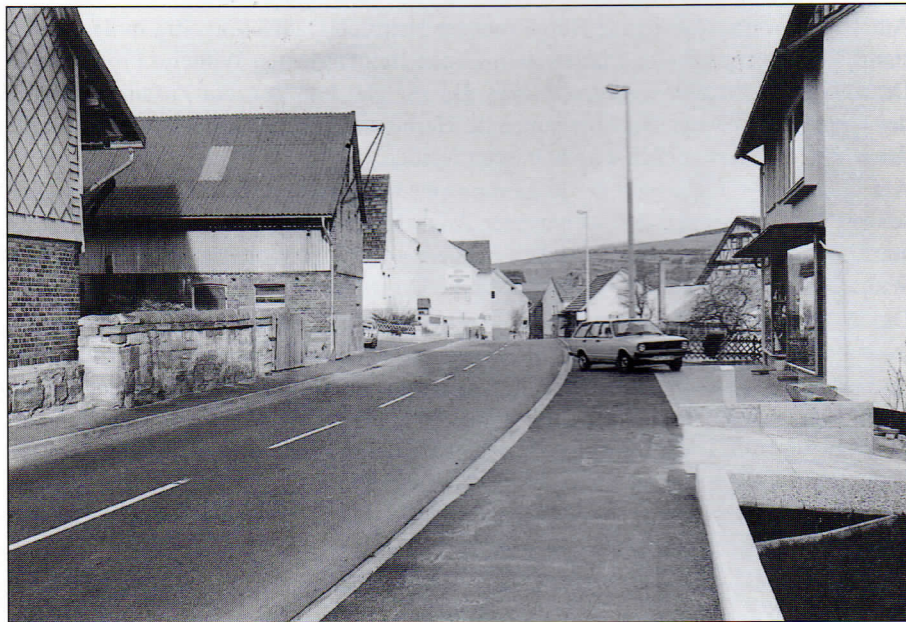
Verrohrung des Mühlgrabens in der Herfaer Straße 1972 – nachher.
