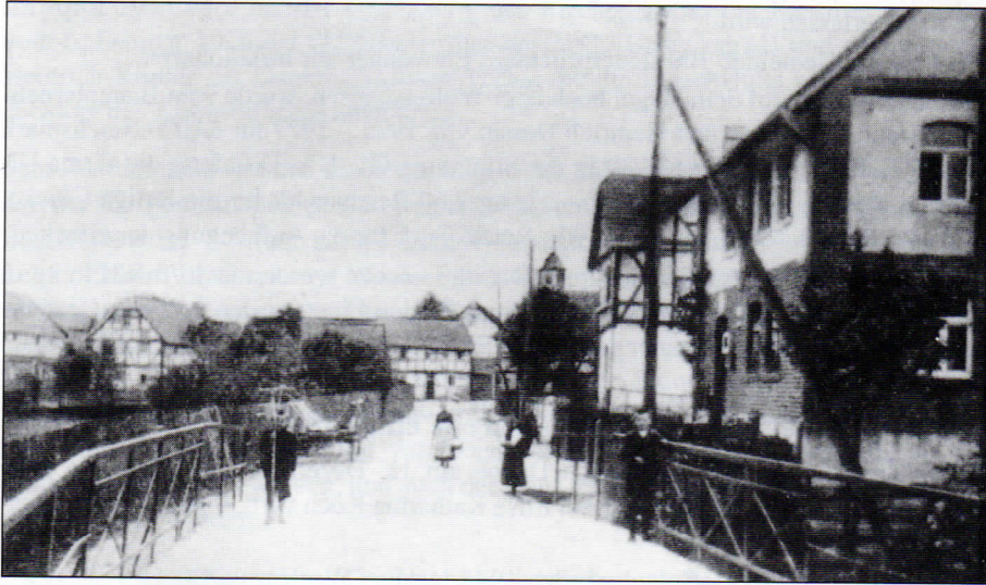
Die Dorfstraße, Brücke zur Winterseite (Lengerser Straße) von 1915. In der Mitte die alte Schule von 1700, rechts die Kirche von 1710.
