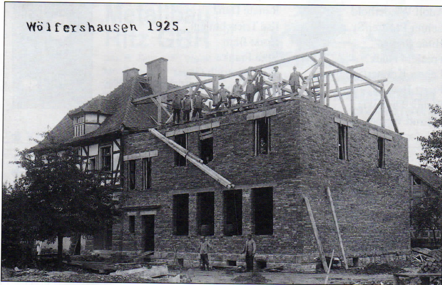
Volksschule/Anbau 1925, drei Klassenräume und zwei Lehrerwohnungen.
