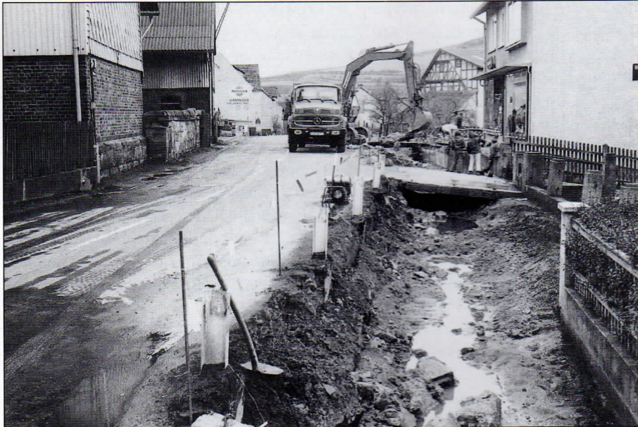
Verrohrung des Mühlgrabens in der Herfaer Straße 1972 – vorher.
