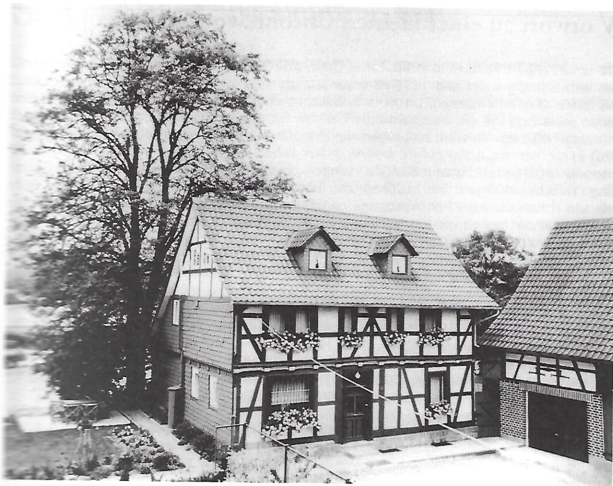
Ehemaliges Wohnhaus der Schmiede in Lengens (nach der Kirche ältestes Gebäude)
